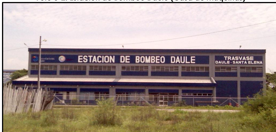
Foto 3-2. Estación de Bombeo Daule (Casa de Máquinas)
