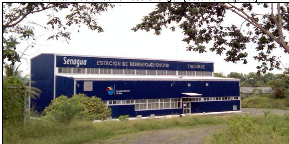
Foto 3-6. Estación de Bombeo Chongón (Casa de Máquinas)
