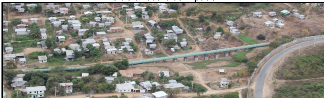
Foto 3-3. Tubería de Impulsión
